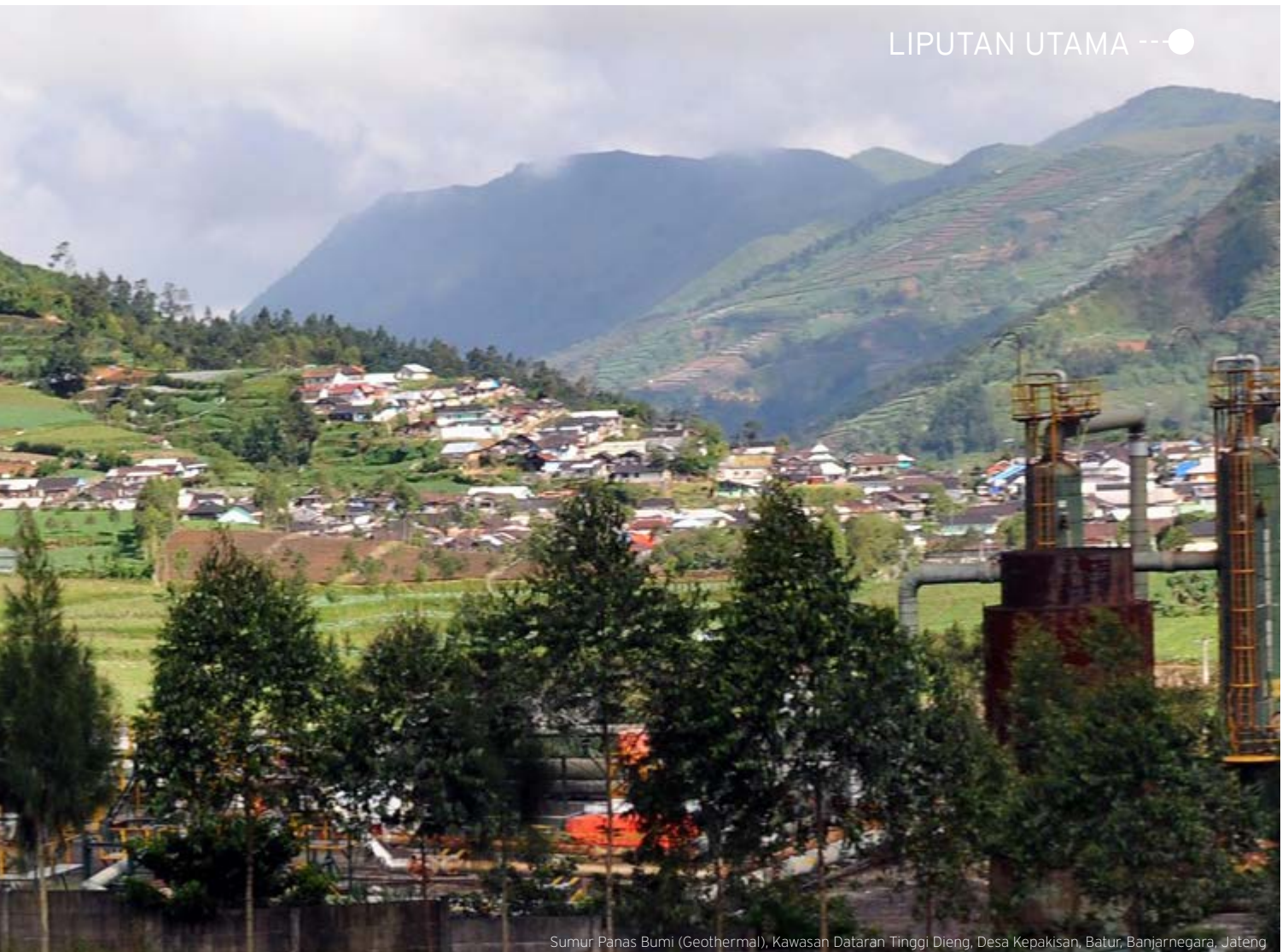
Sumur Panas Bumi (Geothermal), Kawasan Dataran Tinggi Dieng, Desa Kepakisan, Batur, Banjarnegara, Jateng
