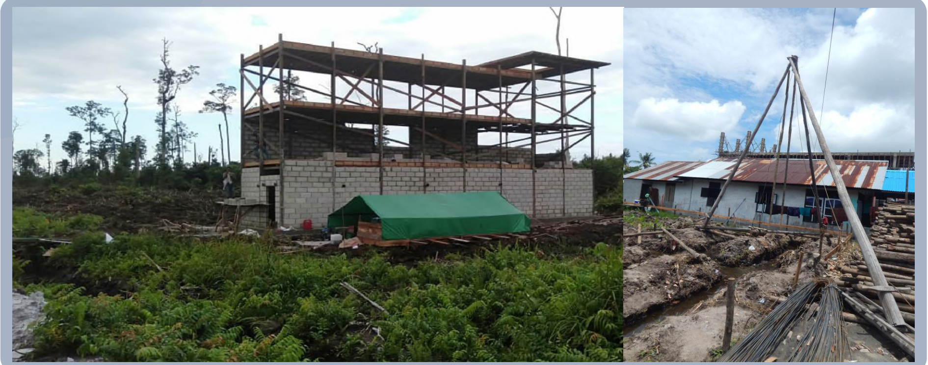
Model adaptasi bangunan diatas tanah lunak (struktur bangunan ringan) di Kalimantan Tengah (kiri) dan penggunaan kayu galam (terucuk) untuk perkuatan pondasi rumah di daerah Ketapang Kalimantan Barat (kanan)
