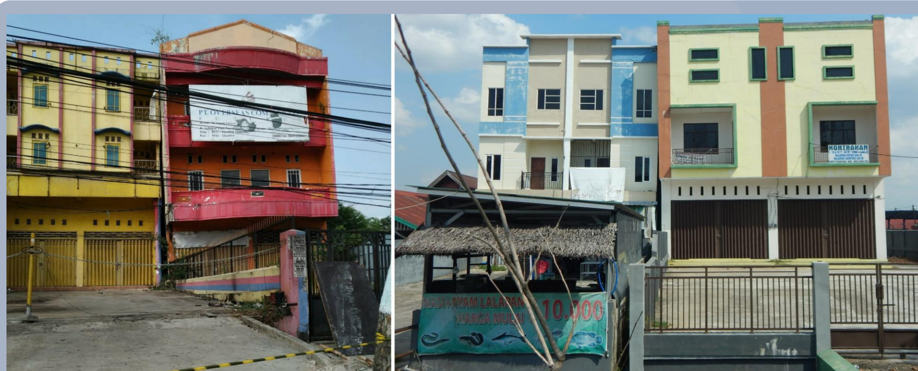
Kerusakan struktur bangunan (gedung terlihat miring) yang dibangun di atas tanah lunak di Kota Banjarmasin, Kalimantan Selatan
