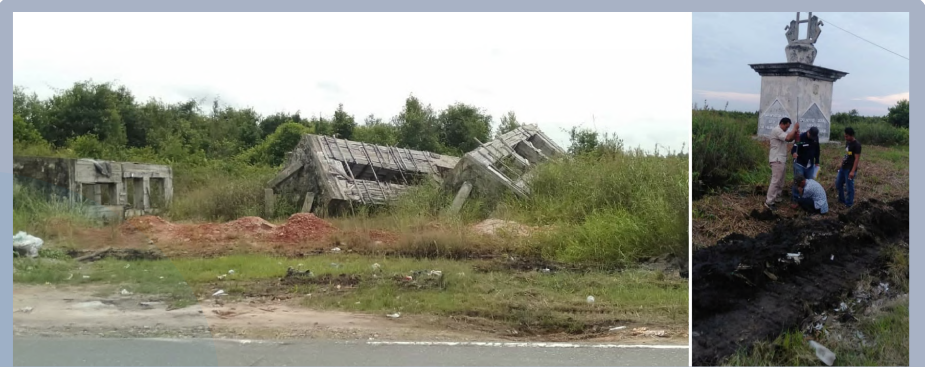
Kegagalan struktur pada bangunan tugu perbatasan yang dibangun diatas tanah lunak di Kabupaten Katingan, Kalimantan Tengah
