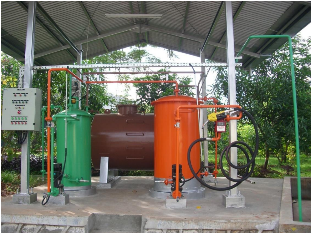
Gambar 4 Unit Blending (tangki hijau: biodiesel; tangki coklat: minyak solar dan tangki oranye: Campuran biodiesel+minyak solar) (Sumber: Dokumentasi Koleksi Oberlin Sidjabat)
