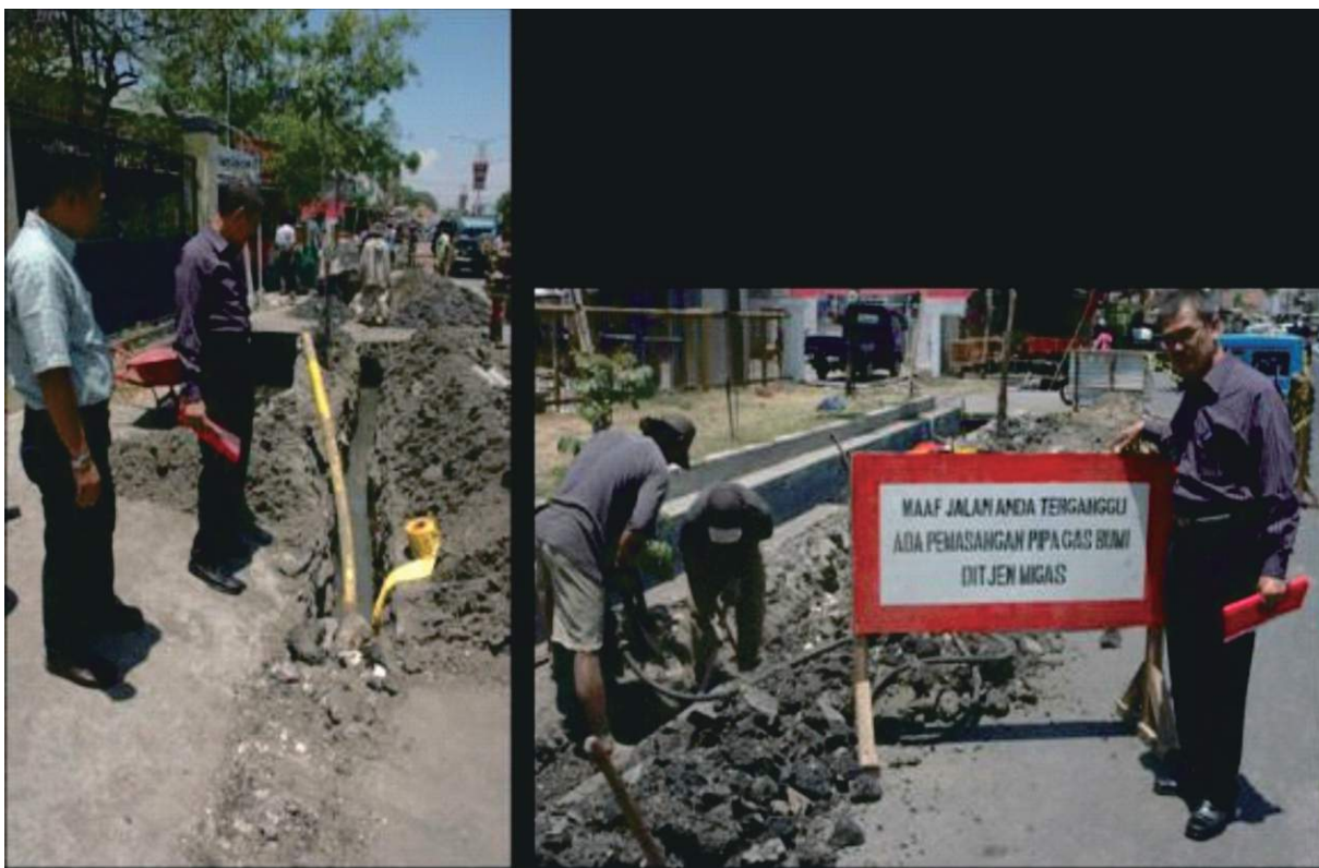
Gambar 5.7. Pembangunan Jaringan Distribusi Gas Bumi untuk Rumah Tangga
