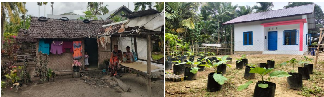
Gambar 15 Rumah dhuafa sebelum dan setelah renovasi
