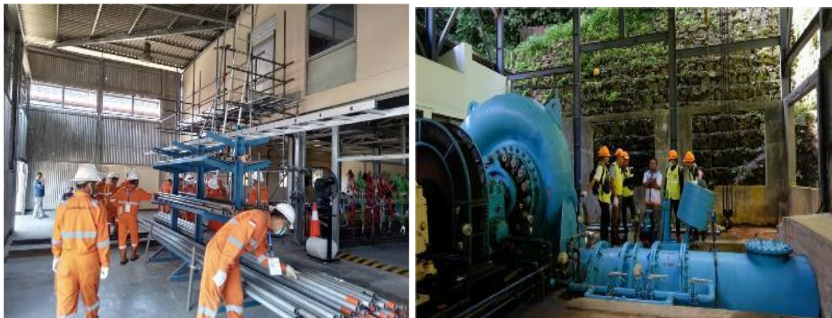
Gambar 3.13 Pelaksanaan Sertifikasi Kompetensi Tenaga Teknik Sektor ESDM di lingkungan satuan kerja BPSDM ESDM; (kiri) Uji Kompetensi Tenaga Teknik Operator Scaffolding yang diselenggarakan oleh PPSDM Migas; (kanan) Uji Kompetensi PLTMH bagi Operator dan/atau Pengelola Angkutan oleh PPSDM KEBTKE.
