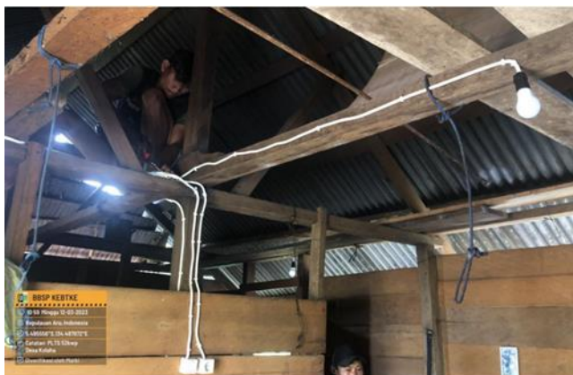
Gambar 3. 98. Pemasangan PLTS TA 2023 di Desa Kolaha, Provinsi Maluku
