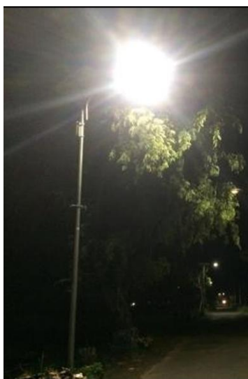
Gambar 3. 87. Pekerjaan Fisik Pemasangan PJU-TS di Kota Sidoarjo
