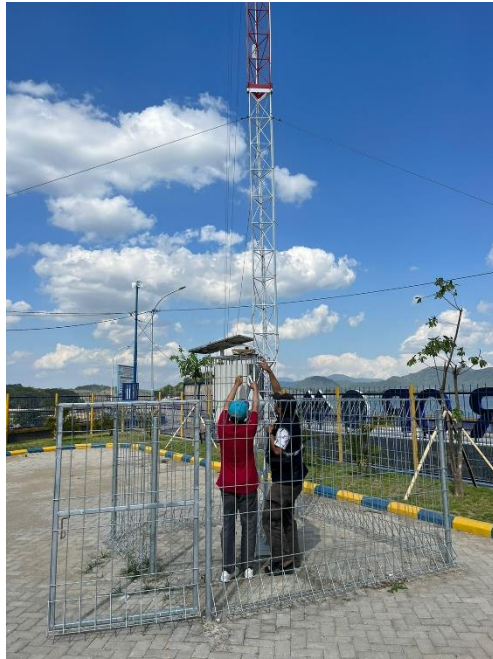
Gambar 3. 7. Pemasangan Alat Ukur Surya Pyranometer di Bendungan Batu Bulan, Sumbawa, Nusa Tenggara Barat
