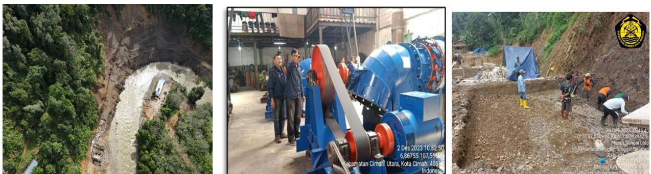
Gambar 3.14 Progres Pembangunan PLTMH Patamuan di Provinsi Sumatera Barat
