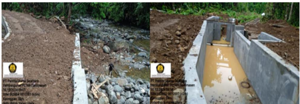
Gambar 3. 18. Pembangunan saluran PLTMH Soromasen, Provinsi Papua
