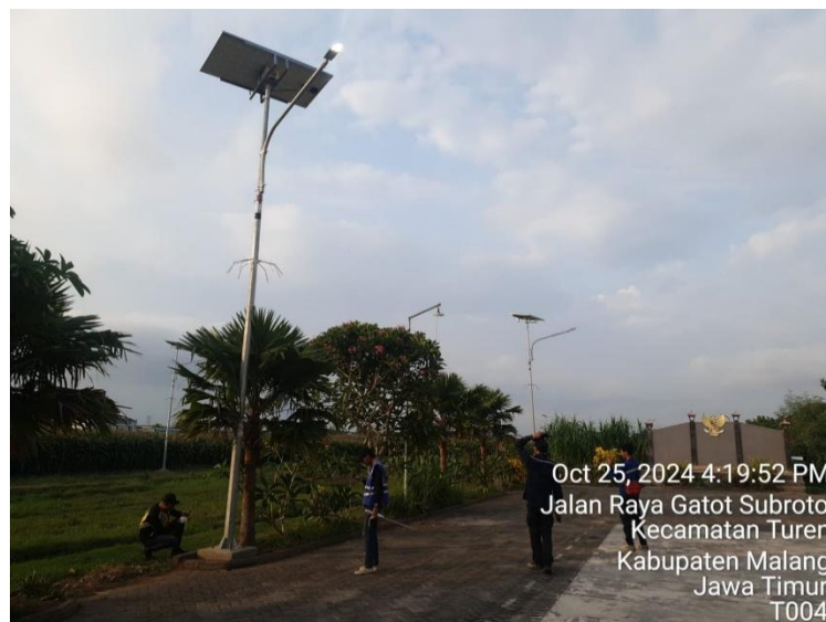
Gambar 3. 22. Pemasangan PJU-TS di Kota Malang
