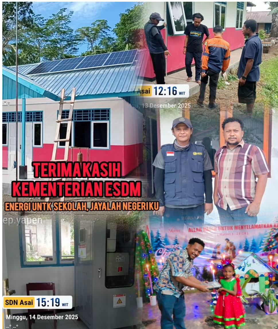
Gambar 4. 16. Pembangunan PLTS Atap di SDN Asai
