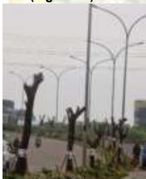
FIGURE 29 Pemindahan Pohon di areal Konstruksi ke areal yang kosong
